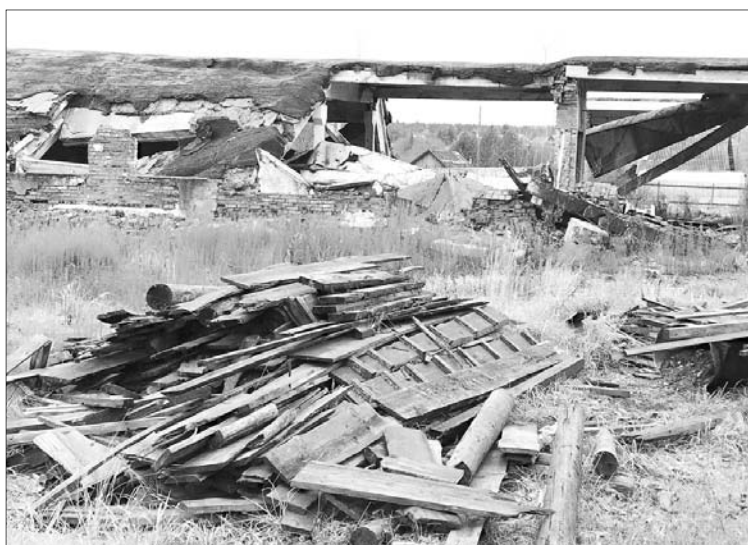
Разрушенное здание планируется снести
