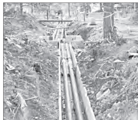
В поселке Заря Вологодского округа ведется ремонт теплотрассы
