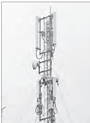
После завершения работ на трассах Вологодчины будут работать 30 базовых станций
