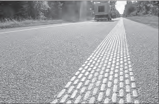
Микронеровности на дорожном покрытии при наезде на них создают вибрацию и характерный шум из-под колёс
