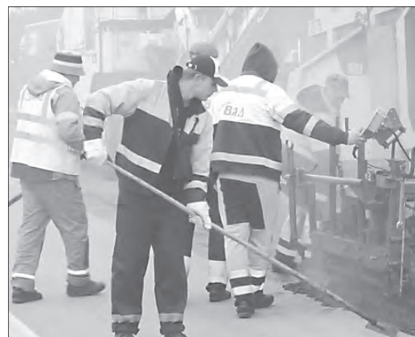
Работы на объекте идут полным ходом
