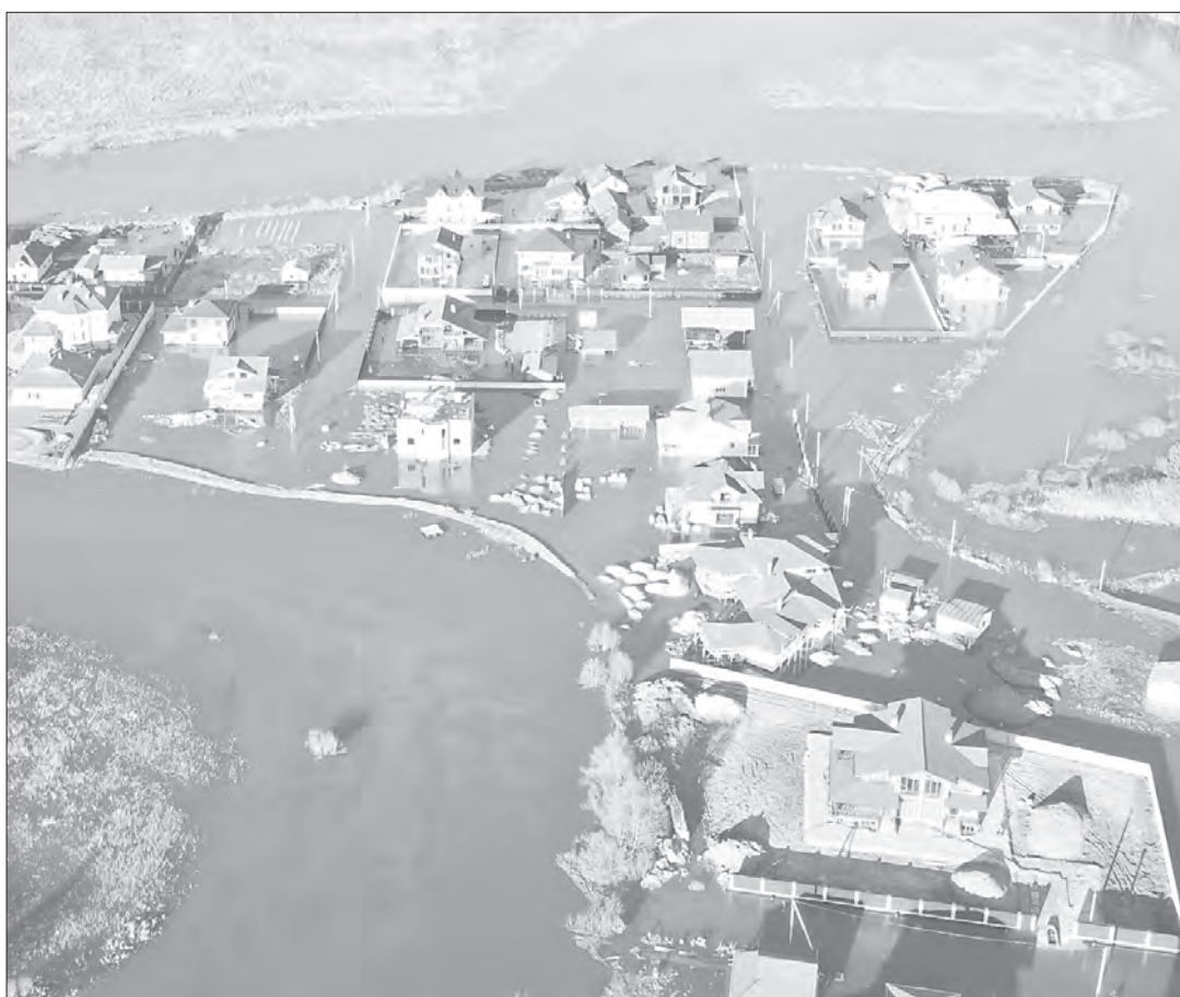
Новый закон предупреждает об опасности возведения жилых домов в зонах подтопления
