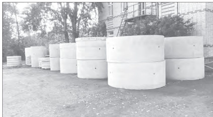
Работы по перекладке водопроводных труб начались по просьбе жителей и включены в Народную программу
