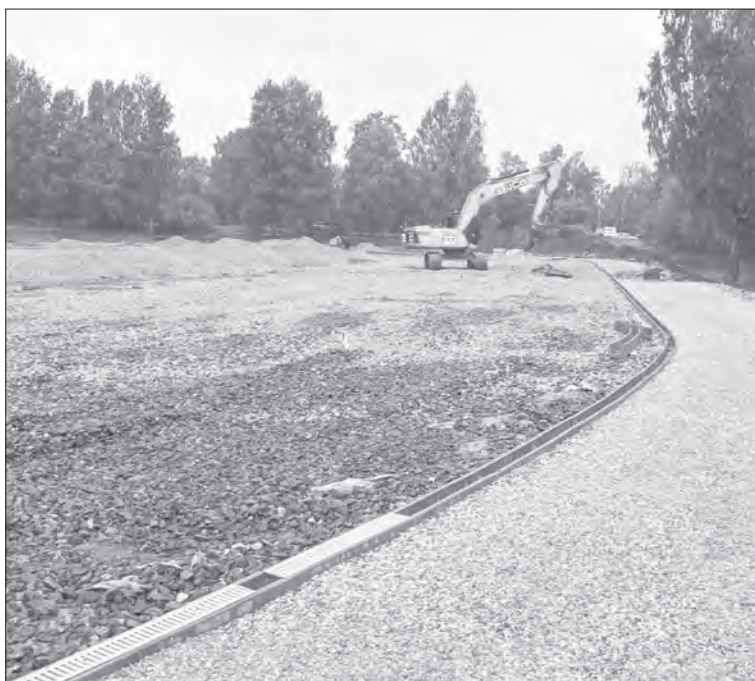
Подрядчик подготовил основание под асфальтирование будущего стадиона
