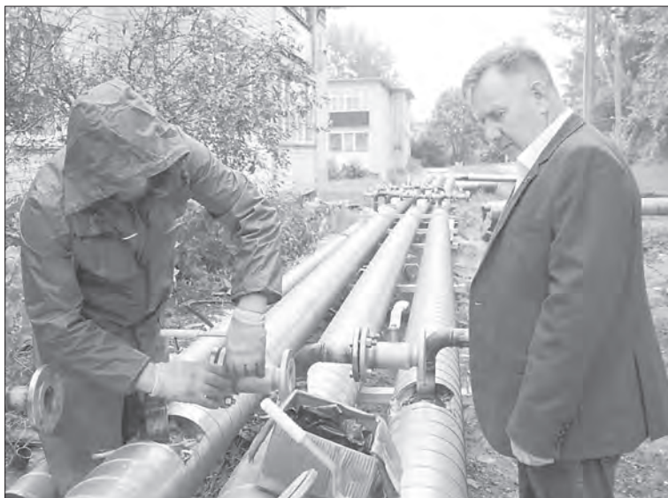
Глава округа Вячеслав Панов проконтролировал ход работ по укладке теплотрассы
