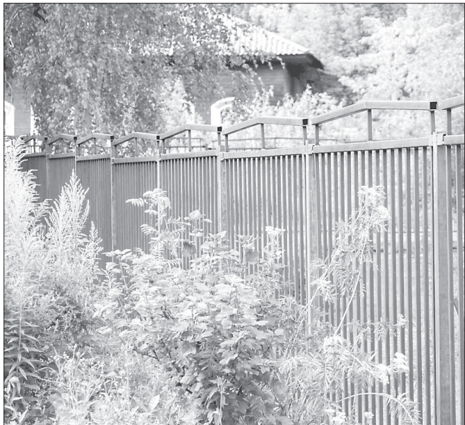
Завершить монтаж ограждения подрядчик должен к началу августа
