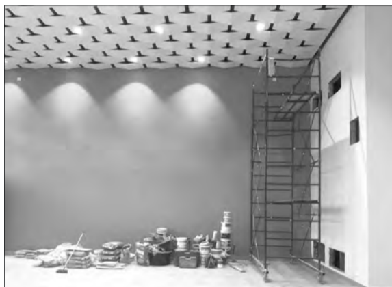
На ремонт здания и внутренней отделки помещений выделено около 15 миллионов рублей
