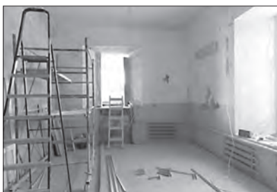
Срок выполнения ремонтных работ по контракту — до 1 июля этого года
