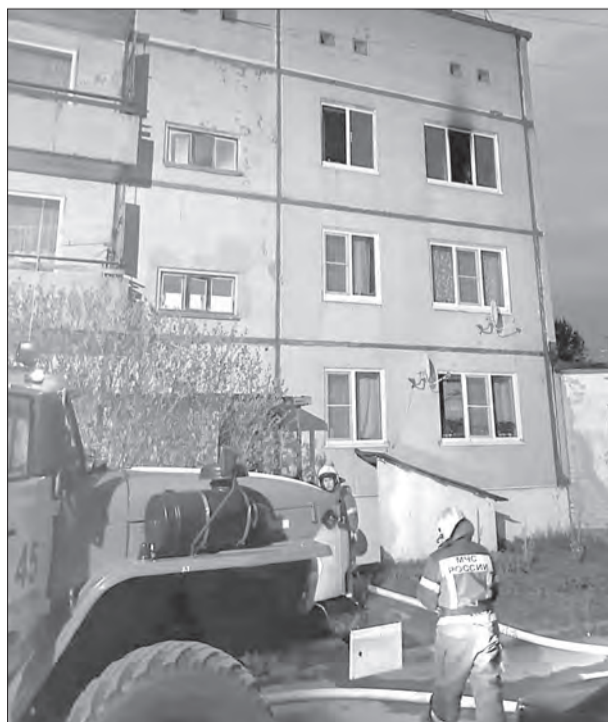
Огонь повредил внутреннюю отделку квартиры
