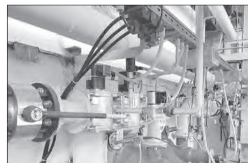
В регионе запланировано построить и реконструировать 97 объектов коммунальной инфраструктуры, из которых 69 — в текущем году
