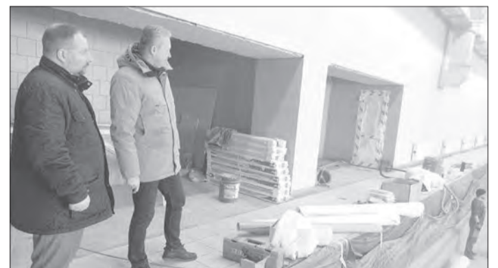
Первый заместитель главы округа Алексей Соколов проверил ход работ
