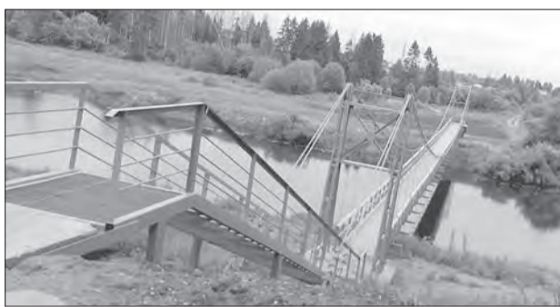
Капитальный ремонт моста через Тошню выполнен в 2024 году спустя 10 лет с момента его постройки
